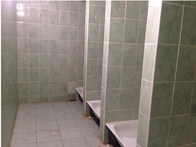
浴室裡有隔間但沒有門，有些樓層的浴室會有浴簾。
