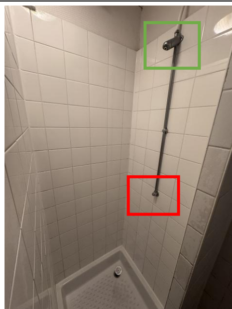
超爆小的淋浴間，紅框是出水扭，綠框是出水孔
